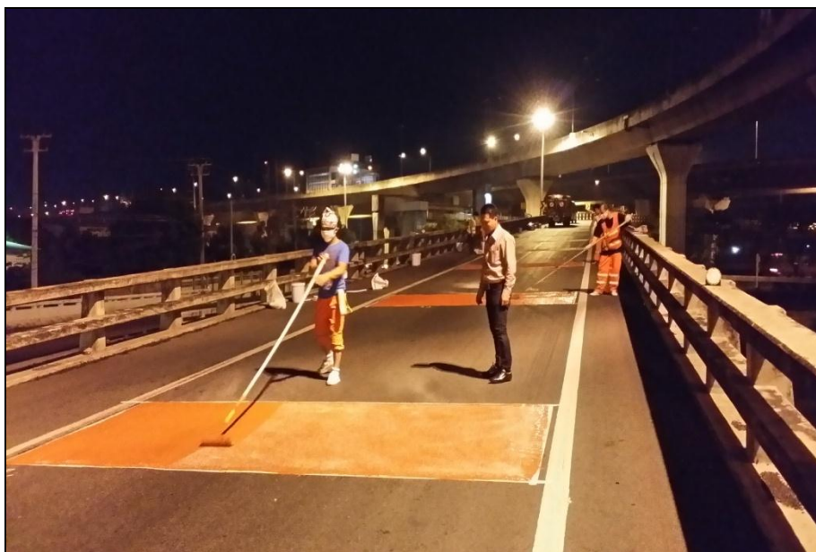
รูปที่ 1.5 ภาพงานฉาบผิวด้วยวัสดุเคลือบผิวจราจร เพื่อลดการลื่นไถล สีแดงบนทางหลวงพิเศษ หมายเลข 9
