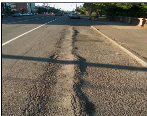
รูปที่ 2.11 ลักษณะผิวทางที่มีลักษณะเป็นร่องล้อ
