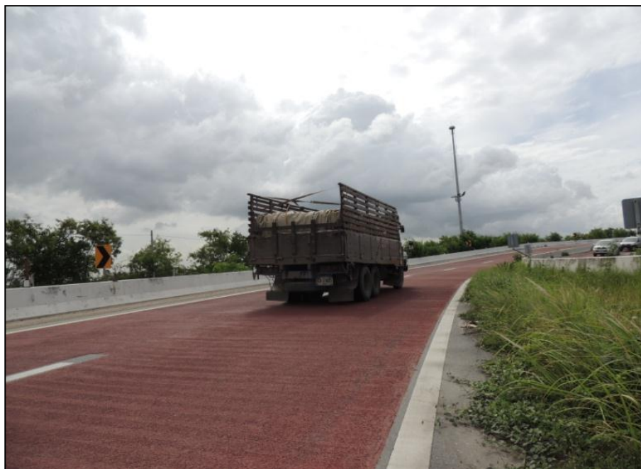
รูปที่ 1.4 ภาพงานฉาบผิวด้วยวัสดุเคลือบผิวจราจร เพื่อลดการลื่นไถล สีแดง บนทางหลวงพิเศษ หมายเลข 7
