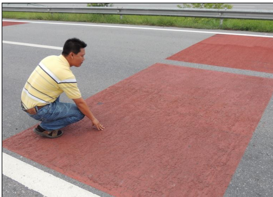
รูปที่ 1.3 ภาพงานฉาบผิวด้วยวัสดุเคลือบผิวจราจร เพื่อลดการลื่นไถล สีแดง บนทางหลวงพิเศษ หมายเลข 7
